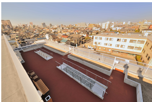
屋上にもリハビリ設備
